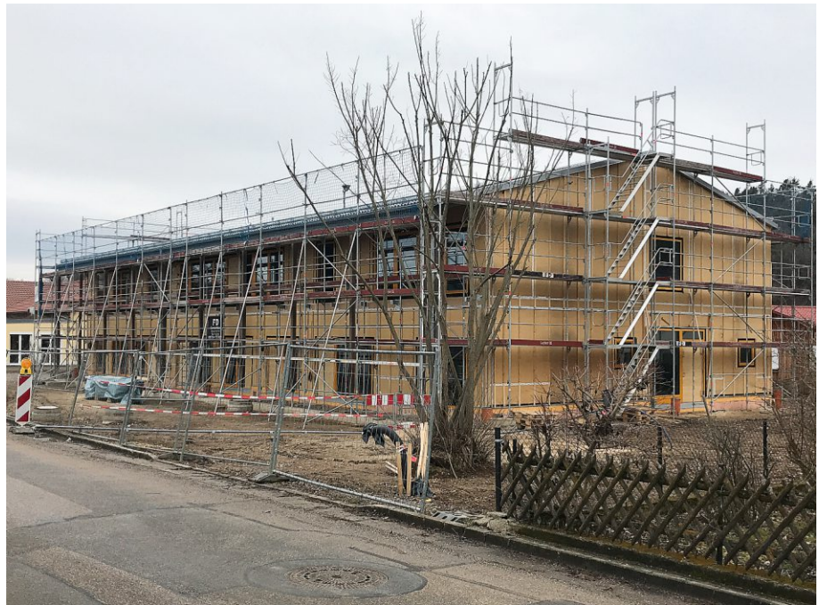
Außenansicht von der Straßenseite im Rohbau
