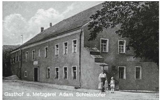
Das Gasthaus Schleinkofer, dessen Tanzsaal regelmäßig in ein Kino verwandelt wurde.
